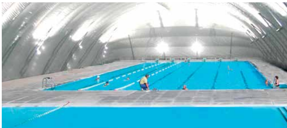
Copertura Valgersa, vista interna
