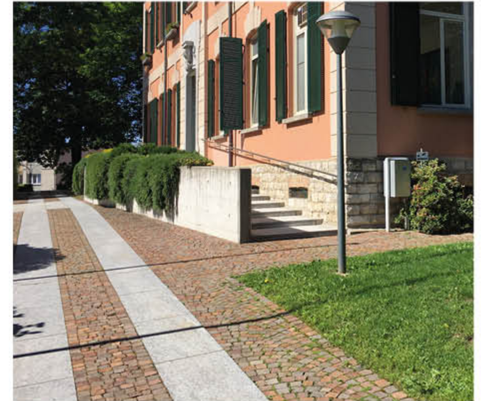
Riutilizzo della pavimentazione in blocchetti di porfido esistente
