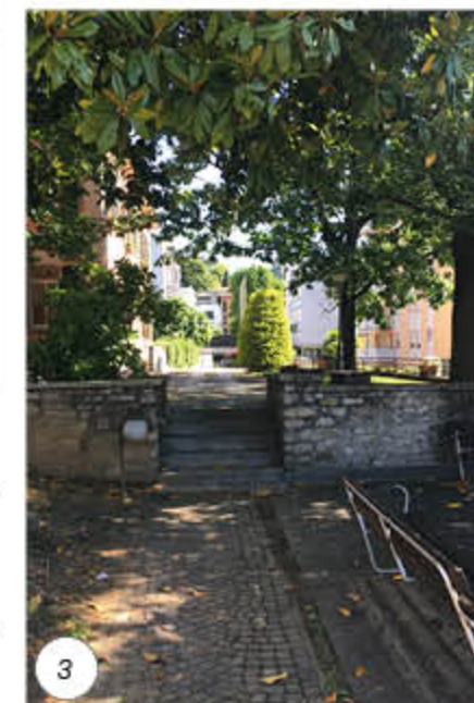
3 Rimozione del muro e della scala e modellazione del terreno per garantire un'accessibilità adeguata
